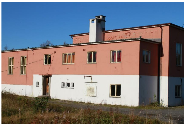
Figur 1 Bergen kringkaster, senderbygning. Foto Lars Ågren
