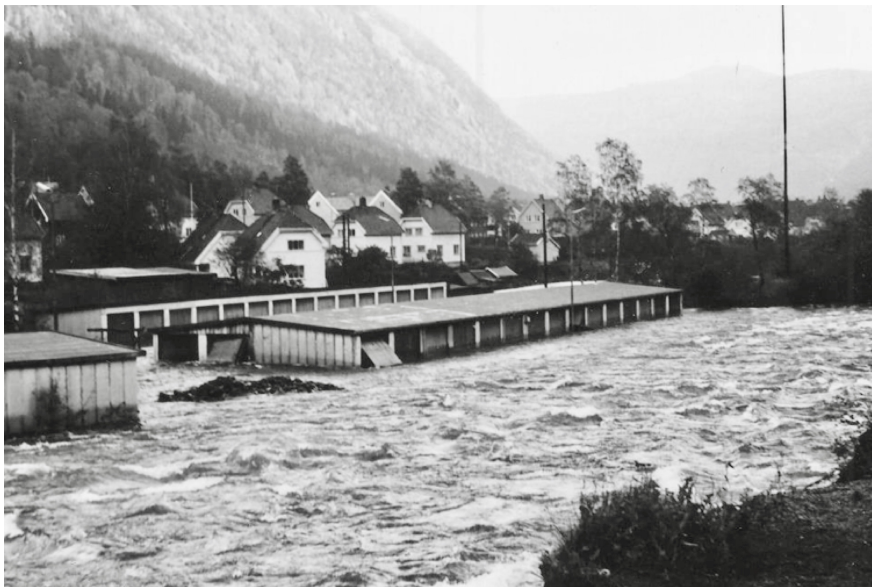
Storflom 1967 på Rjukan. Bildet viser senderanlegg #3 for LKR. Radiomast på elvebredden i Blindtarmen, med senderhuset bak stolpen ved garasjene. Bilde: Ukjent.
